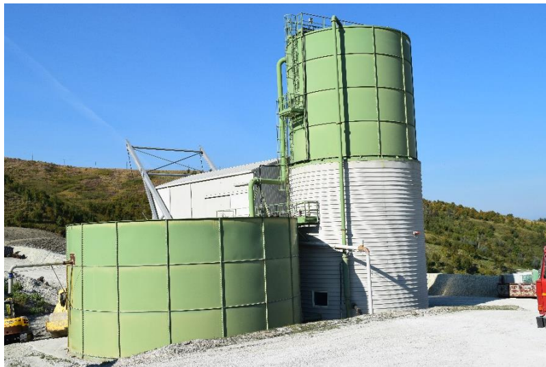
FIGURA 20 - IMPIANTO DI CHIARIFICAZIONE E RICICLO ACQUE REFLUE 1 - CAVA "RIPA CALBANA" - BORGHİ (FC)
