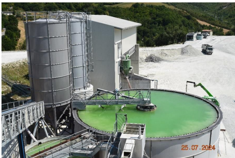
FIGURA 22 - VISTA DELL'IMPIANTO DI CHIARIFICAZIONE E RICICLO ACQUE REFLUE 2 CALBANA POST-INSTALLAZIONE DEL SECONDO SILOS LIMI - CAVA "RIPA CALBANA" - BORCHI (FC)
