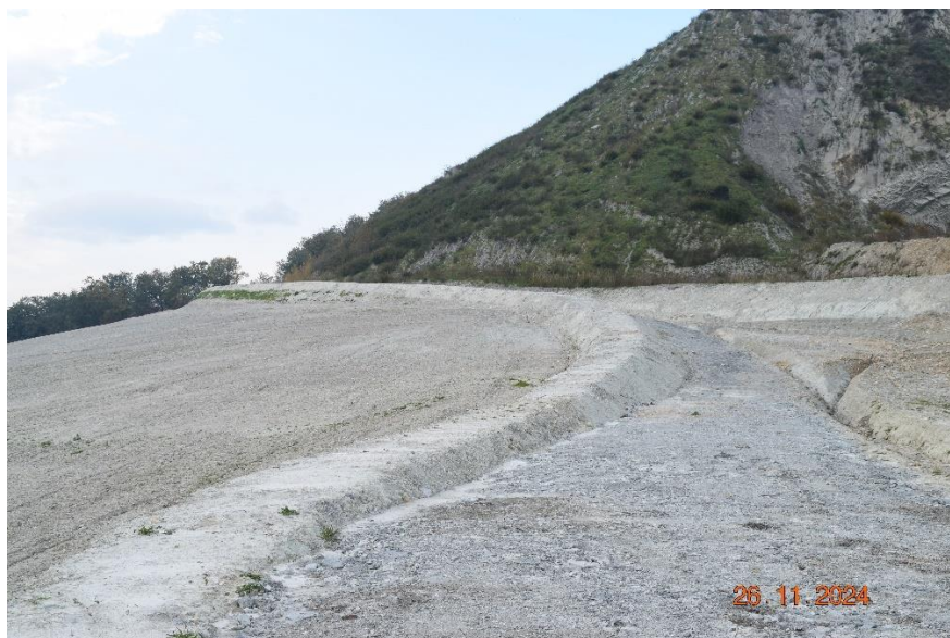
FIGURA 15 - VISTA DELLA CONDOTTA A CIELO APERTO CON ARGINE DI PROTEZIONE LATO MASROLA - CAVA "RIPA CALBANA" - BORGI (FC)
