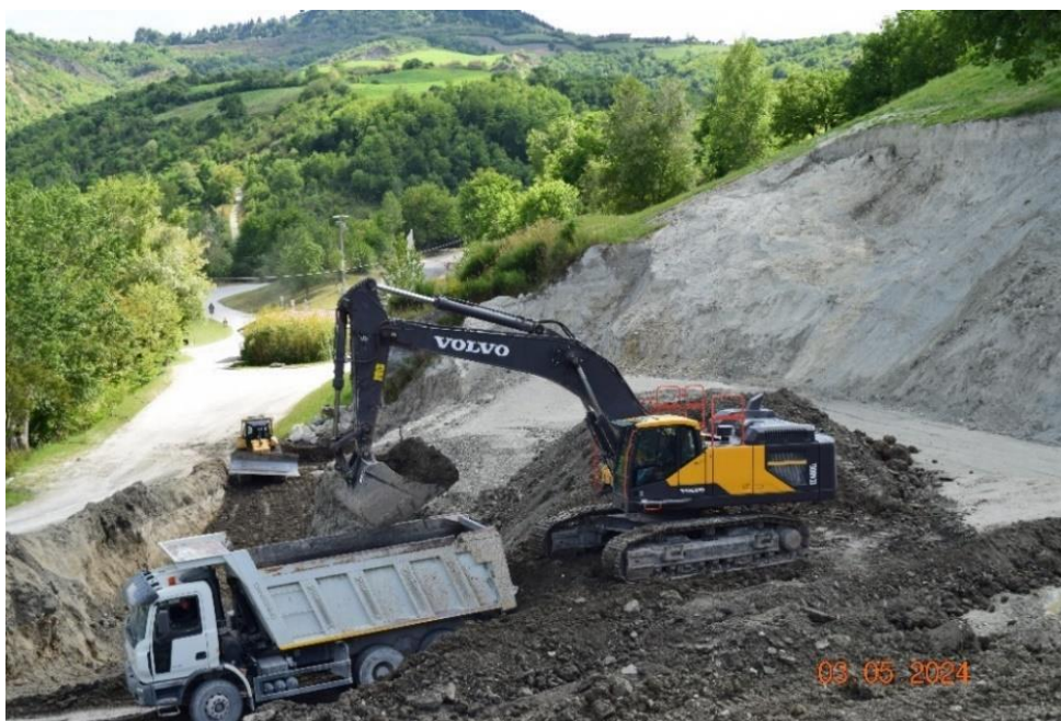
FIGURA 17 - LA FOTO EVIDENZIA LA FASE INIZIALE DI PREDISPOSIZIONE DELLE BRIGLIE DI FONDAZIONE – CAVA "RIPA ALBANA" - BORGI (FC)
